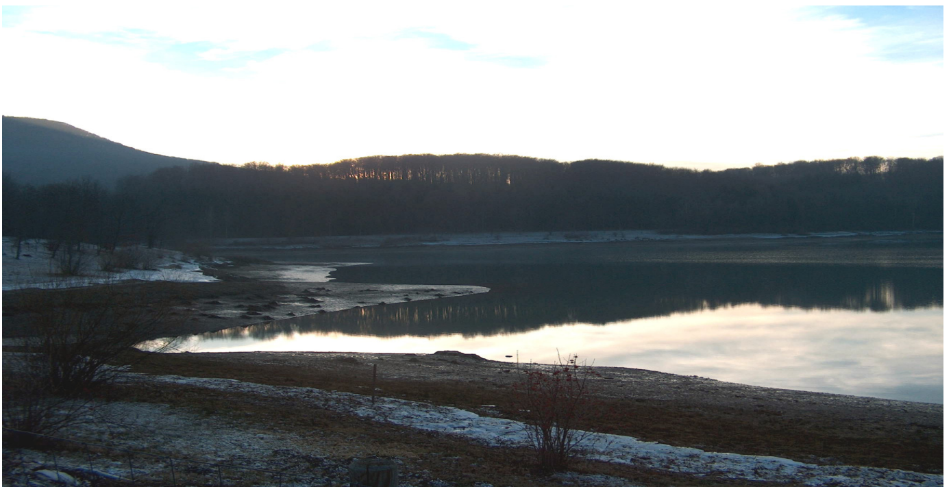
Pumpspeicherwerk Glems ( Unterbecken )
